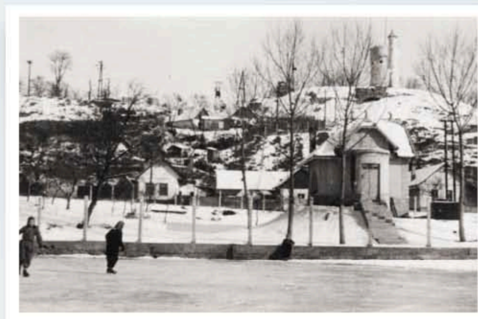
BÝVALÁ STROJOVNÁ - GÉPHÁS
